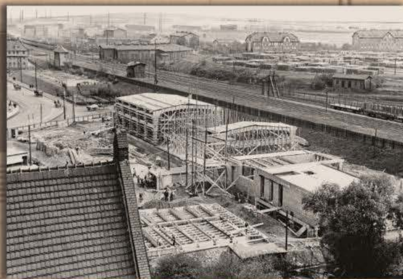
Hala targowa podczas budowy (październik 1938 r.); fot. Narodowe Archiwum Cyfrowe
